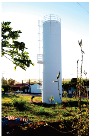
Dinheiro público mal gasto. Perfuração de poço semiestructural e implantação de reservatório em local mal planejado geram revolta na população, que sofre com a falta de água.
