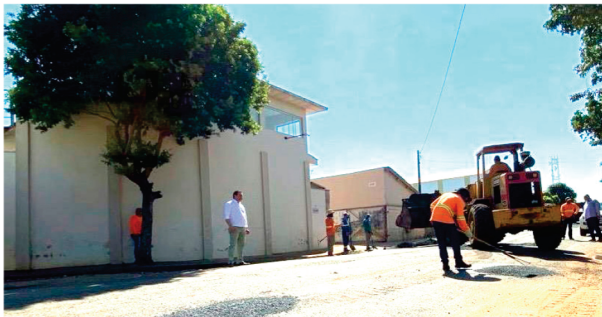
Com trabalho contínuo de manutenção e planejamento, Administração Municipal intensifica recuperação das vias públicas e prepara novas etapas de pavimentação.
